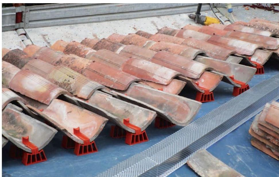
tivazione di moti convettivi ascensionali che sottraggono gran parte del calore, che altrimenti si trasmetterebbe agli strati sottostanti; permette quindi il contatto diretto tra i coppi e la camera di ventilazione per sfruttare il rapido riscaldamento dell'aria sottocoppo e accentuarne la velocità di deflusso attraverso il colmo di ventilazione. Il fissaggio dei coppi di canale e di coperta, tramite la catenaria costituita dalle staffe dei piedini e dai ganci metallici, non necessita di
