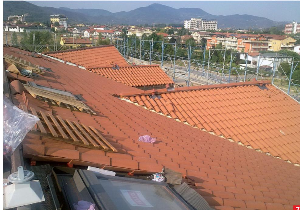
**1-2-3. Piedino di rialzo e bloccaggio dei coppi di canale in polipropilene copolimero stabilizzato ai raggi Uva da applicare a ogni coppa di canale (n. 15/m<sup>2</sup>), consente di ottenere la camera di ventilazione. È munito di dentelli antiscivolo per ancorarsi alla struttura e di una speciale staffa per agganciarsi al coppo successivo.**
