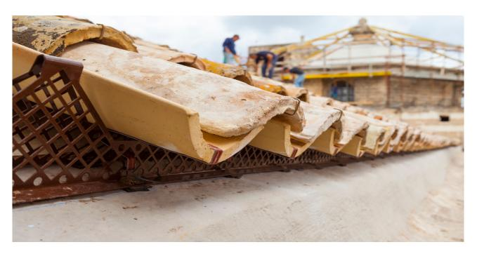
L'Arch. Longo conferma i vantaggi dell'impiego di AERcoppo® che erano stati preventivati in fase di progetto: "Dopo la stesura dell'impermeabilizzante abbiamo iniziato a posizionare gli elementi del sistema. La soluzione ci è sembrata fin da subito vincente per la sua flessibilità, leggerezza, ma soprattutto per la capacità di garantire ventilazione alla copertura. Il manto è così più sano e anche gli strati sottostanti possono godere di migliori condizioni anche durante il periodo molto caldo".
