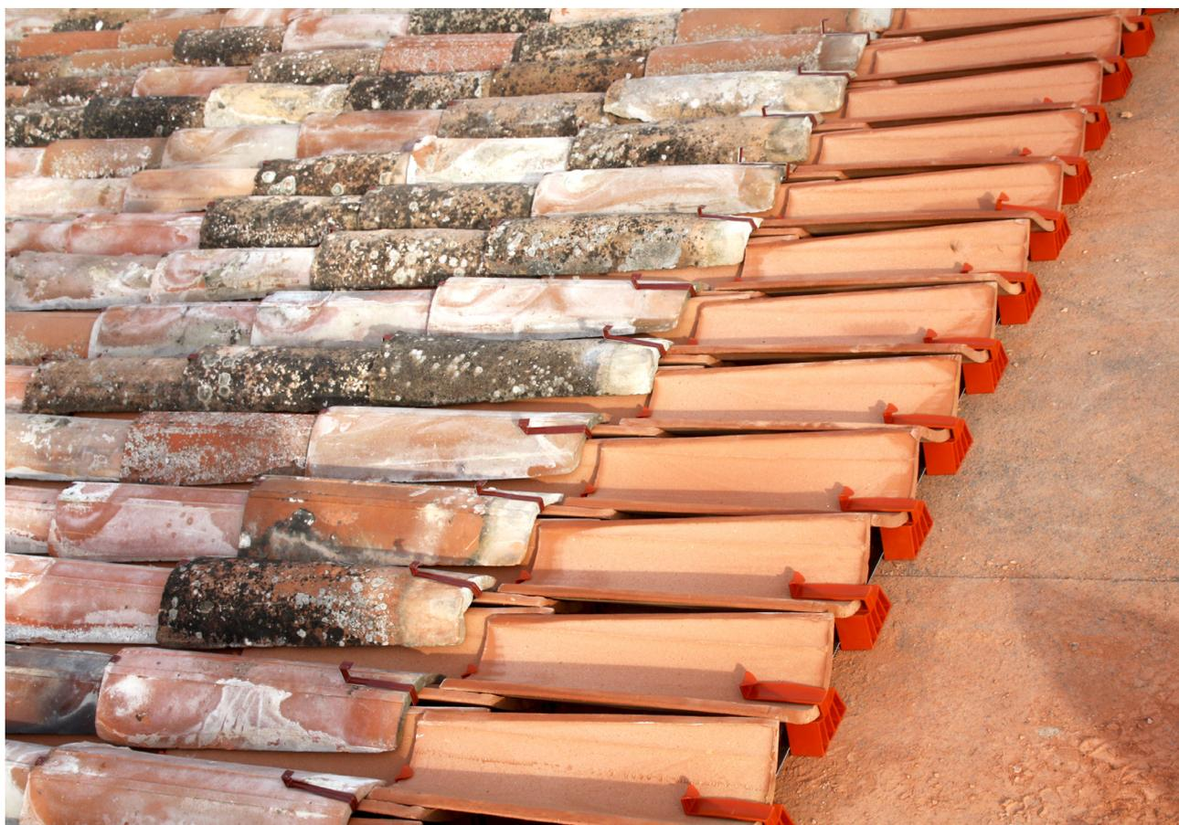
*“Il sistema AERcoppo® si è rivelato perfetto per questo intervento - sintetizza **Fabio Merlin**, titolare dell’impresa esecutrice - i supporti sono leggeri ma resistenti e consentono massima flessibilità progettuale. Inoltre evitano di dover forare la guaina prevenendo la perdita delle prestazioni complessive del pacchetto di copertura. Il sistema AERcoppo® permette di ottenere un’adeguata ventilazione della copertura, che abbiamo già potuto riscontrare dopo la conclusione dei lavori”.*
