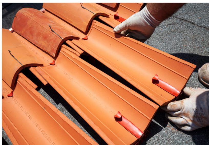
Dopo la posa dello strato isolante e della barriera impermeabilizzante è stato posato il sistema AerCoppo per la ventilazione del manto
