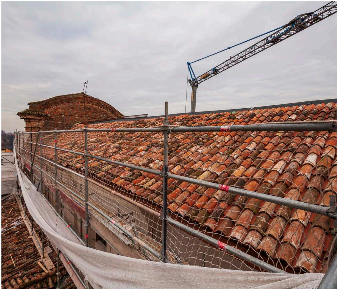
La copertura della chiesa è composta da una volta per quanto riguarda la navata centrale, che termina in una crociera e da una struttura pentagonale a spicchi, per quanto riguarda l'abside. Una geometria piuttosto complessa che deve essere valutata in sede decisionale, per risolvere e prevenire la regolarizzazione degli allineamenti del manto.
