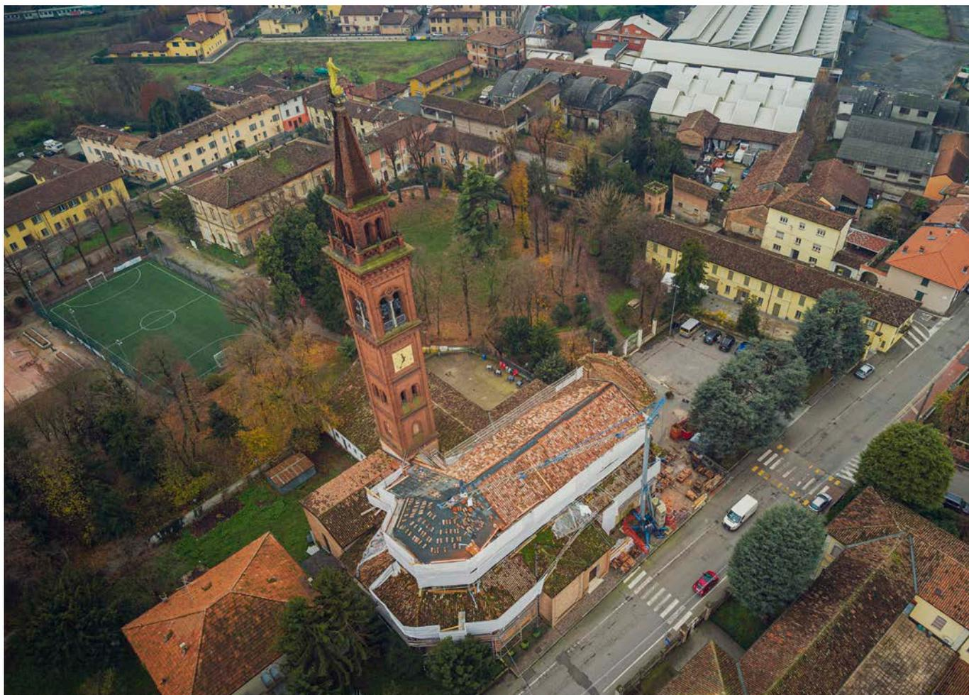
Per ottenere un manto di copertura il più possibile fedele all’originale i coppi esistenti ed in buono stato sono stati recuperati e tagliati, laddove necessario, per uniformarsi alle lunghezze dei nuovi, così da assicurare allineamenti pressochè perfetti.
