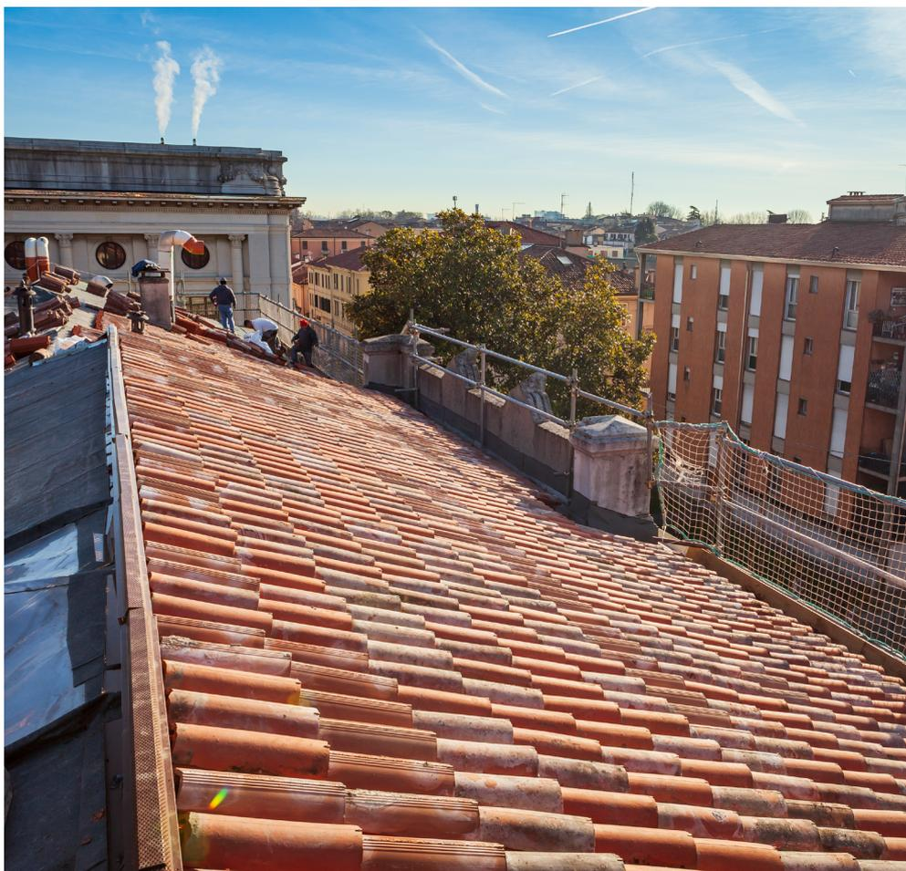
L'Arch. Marco Canton, Assistente del RUP, ci racconta come si sia lavorato per concentrare i sistemi di espulsione dei fumi dei laboratori, razionalizzandone il numero e la posizione sulla copertura: *"Abbiamo realizzato quattro nuovi elementi in copertura, che ci hanno permesso di concentrare i collettori di espulsione ed evitare la loro distribuzione casuale, oltre a minimizzare il proprio impatto anche dal punto di vista estetico"*.
