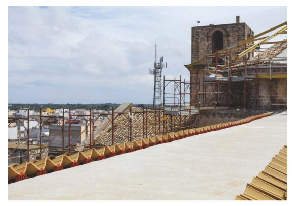
Soluzioni costruttive performanti e appropriate alle delicate preesistenze storiche per i lavori di riqualificazione del tetto ammalorato della Basilica di Santa Maria della Vittoria: un recupero, sviluppato in collaborazione con la Soprintendenza per i Beni Architettonici e Paesaggistici, che ha visto lavorare in team progettisti e realizzatori sin dalla scelta del sistema di copertura ventilata AERcoppo® di AERtetto, semplice da posare, leggero e versatile.
