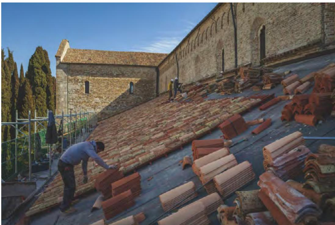
Soluzioni costruttive performanti e appropriate al valore storico dell'edificio, per i lavori di rifacimento del manto di copertura delle campate laterali della Basilica di Santa Maria Assunta di Aquileia: un intervento di manutenzione (reso necessario dallo stato di ammaloramento) che ha visto lavorare in team progettisti e realizzatori sin dalla scelta del sistema di copertura ventilata AERcoppo® di AERTetto, semplice da posare, leggero e versatile.
