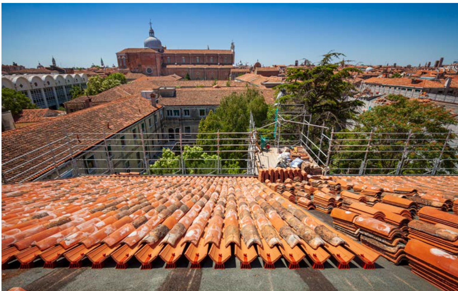
Le coperture della Chiesa di San Lazzaro dei Mendicanti e dei Padiglioni nord e sud sono state recuperate con il sistema AERcoppo®, un tetto ventilato posato a secco che non fora la guaina impermeabilizzante adattandosi a qualsiasi pendenza delle falde.
