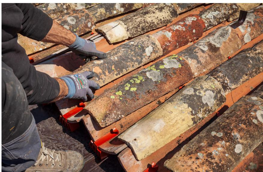
La completa ricostruzione del manto di copertura di due porzioni della storica struttura medievale ha permesso di migliorarne sicurezza e funzionalità senza alterarne l'aspetto. La flessibilità del sistema AERCoppo® ha consentito di assecondare i cambi di pendenza e le variazioni di quota del tetto e di riutilizzare i coppi originari recuperati per lo strato di finitura superiore.
