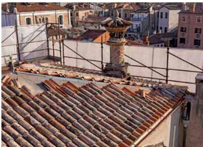
con altri elementi in laterizio. In accordo con l'impresa che ha realizzato la copertura abbiamo preferito inserire tavolati in legno, che ci sembravano un supporto migliore per l'appoggio del sistema proposto da AERtetto". Sopra le tavelle è stato steso un doppio strato di guaina impermeabilizzante a freddo e si è provveduto poi al posizionamento di AERCoppo. Una scelta condivisa da tutti i protagonisti dell'intervento, sia dai progettisti, che dall'impresa.
