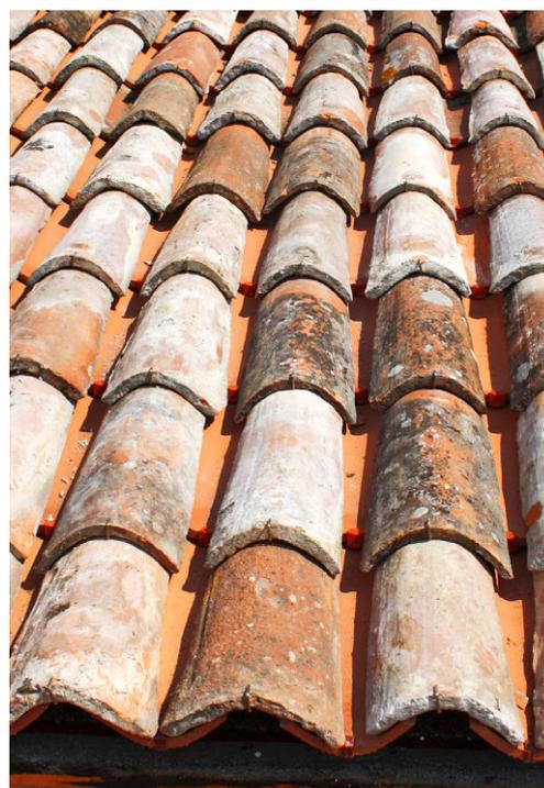
Il sistema AERcoppo® ha infatti permesso di riposizionare il manto in coppi, recuperando laddove possibile gli elementi originali che sono stati posizionati lungo il profilo di gronda e integrandoli con coppi nuovi, man mano che si saliva verso il colmo.
