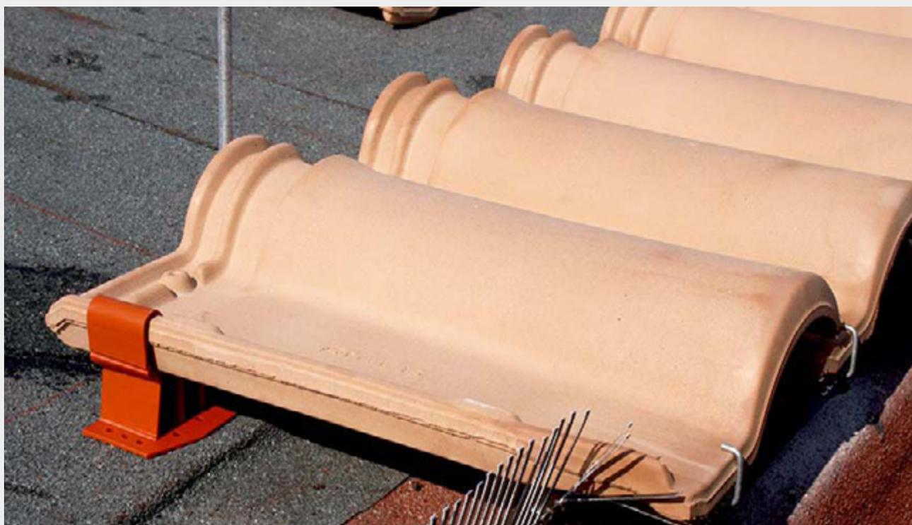
Il sistema si adatta a qualsiasi tipo di pannello coibente o struttura di supporto, rendendolo ideale sia per nuove costruzioni che per interventi di riqualificazione o ristrutturazione edilizia. La posa semplice e veloce, conforme alla Norma UNI 9460 del 2023, può essere eseguita anche da maestranze non specializzate, garantendo una copertura sicura, duratura e rispettosa dell'estetica tradizionale.
