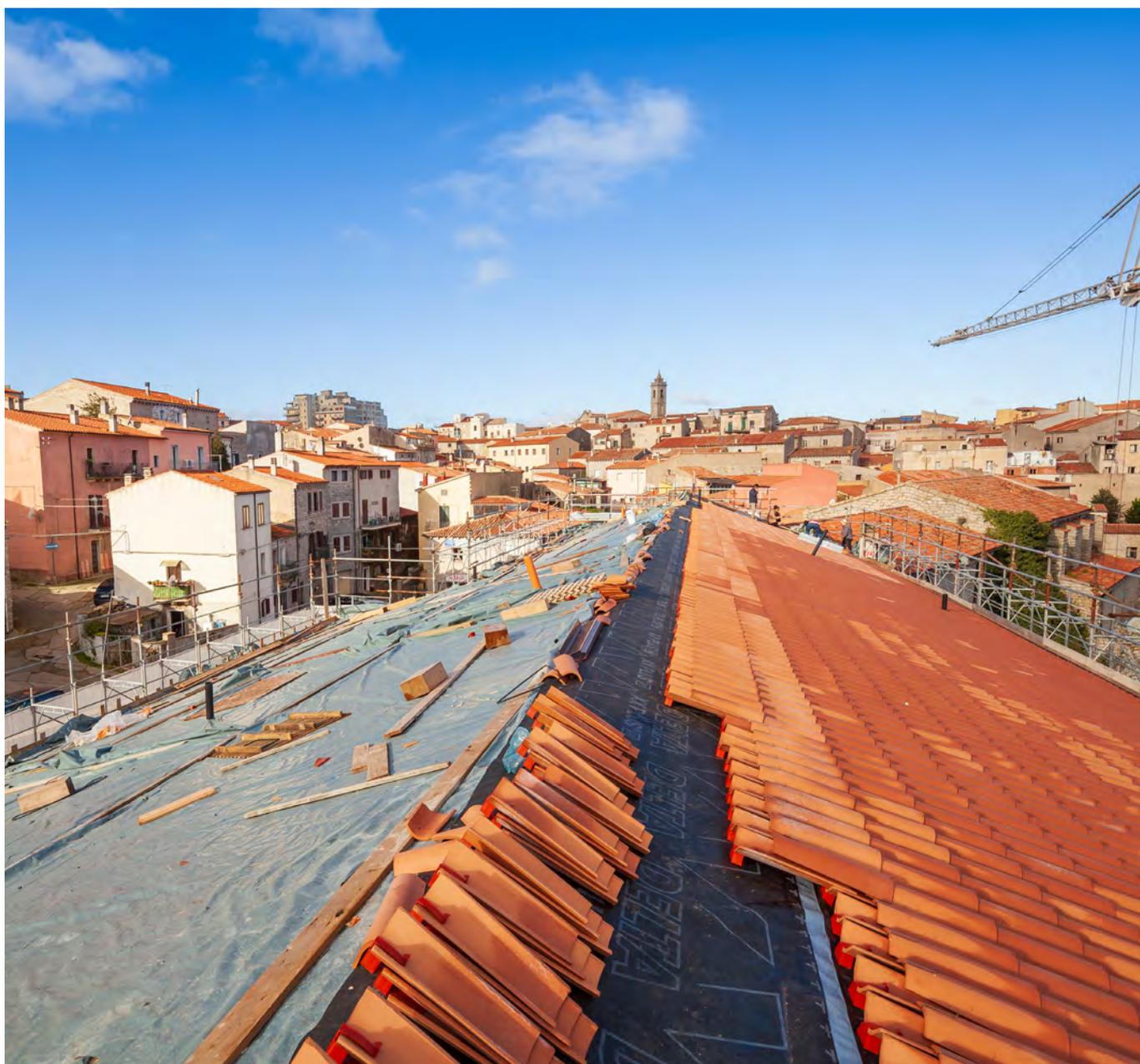
L'Arch. Angela Zattera entra ancora di più nei dettagli: "l'edificio era aggredito dalla vegetazione infestante che nel tempo si è stratificata, le murature e le strutture orizzontali erano in parte compromesse sia dalle infiltrazioni di umidità che da alcuni dissesti. Il sistema costruttivo dell'Ex Gauss era costituito da strutture verticali in muratura portante in pietra e orizzontamenti voltati sia a livello intermedio che a livello di copertura.
