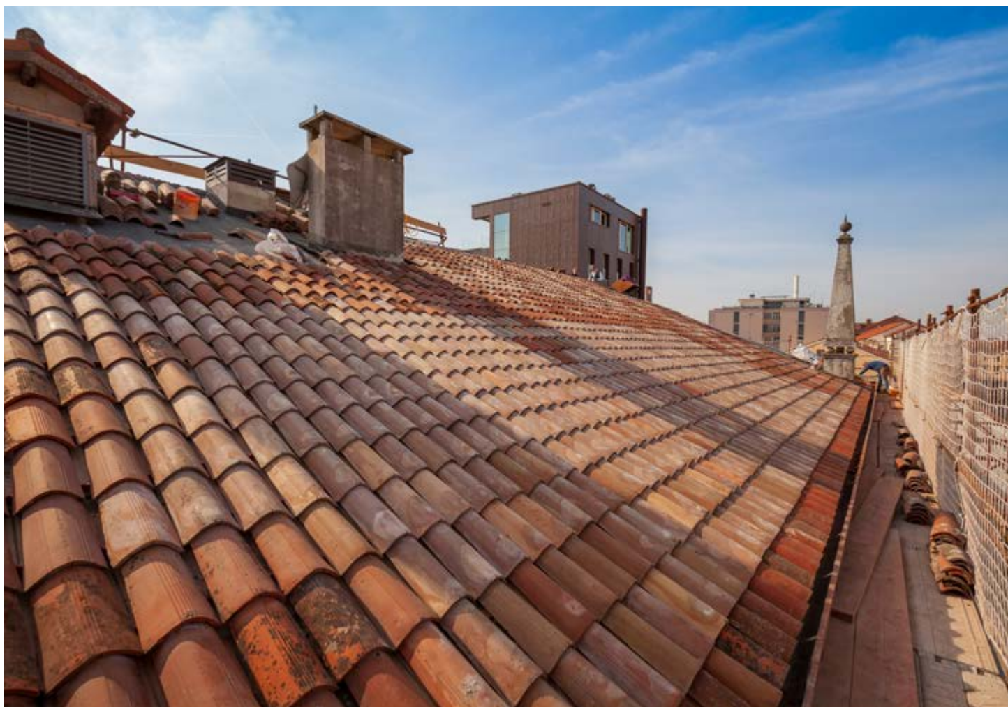
Nel rifacimento della copertura di Palazzo Venezia, la creazione di un nuovo manto ventilato non ha escluso il recupero dei coppi esistenti, mixandoli con alcuni elementi nuovi per creare quell'equilibrio cromatico richiesto dalla Soprintendenza.
