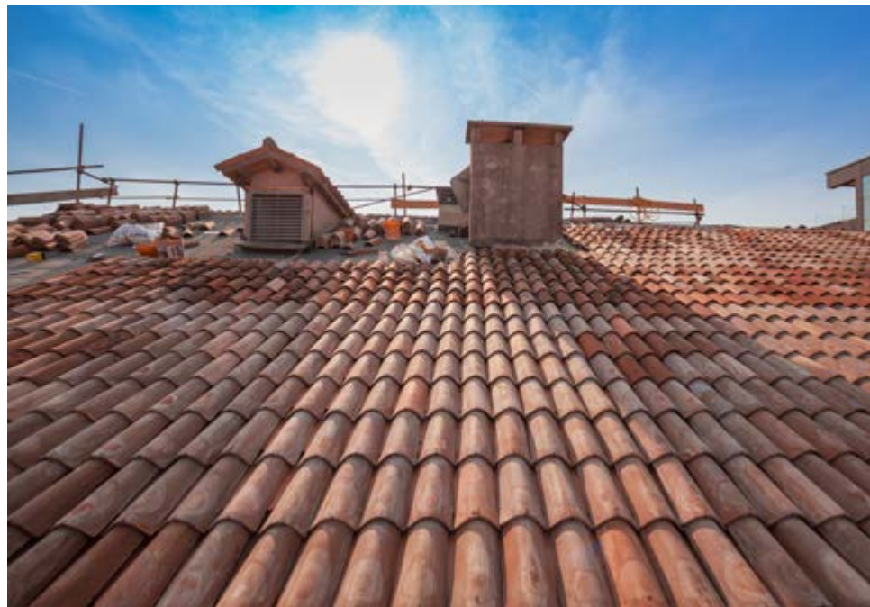
Nel rifacimento della copertura di Palazzo Venezia, la creazione di un nuovo manto ventilato non ha escluso il recupero dei coppi esistenti, mixandoli con alcuni elementi nuovi per creare quell'equilibrio cromatico richiesto dalla Soprintendenza.
