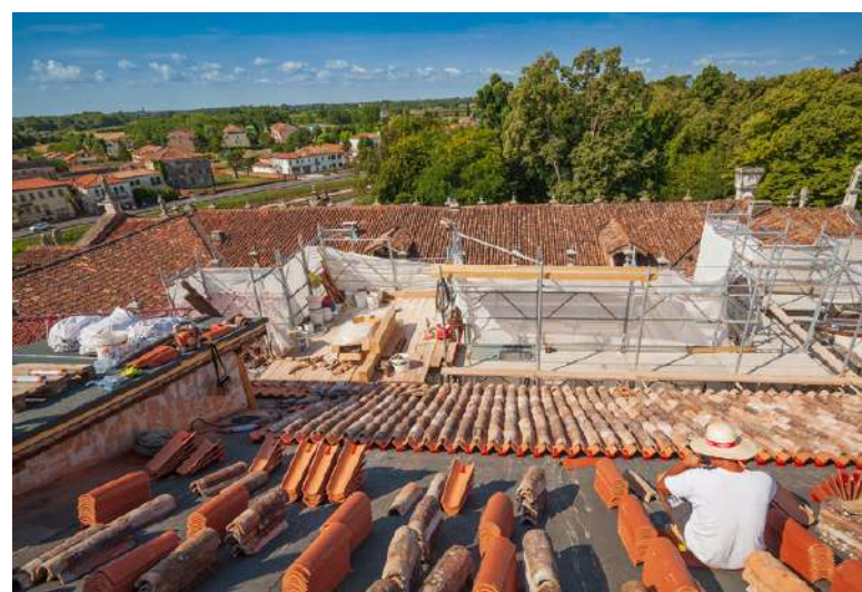
Nella storica Villa Pisani era diventato essenziale intervenire sulle coperture, in particolare quella dell'antico salone da ballo sulla cui cupola dimora un affresco di Tiepolo. Verificata la struttura portante lignea e inserito un nuovo pacchetto isolante, il sistema AERcoppo® ha permesso la posa dei coppi senza forare la guaina impermeabilizzante e, al contempo, la ventilazione del manto.
