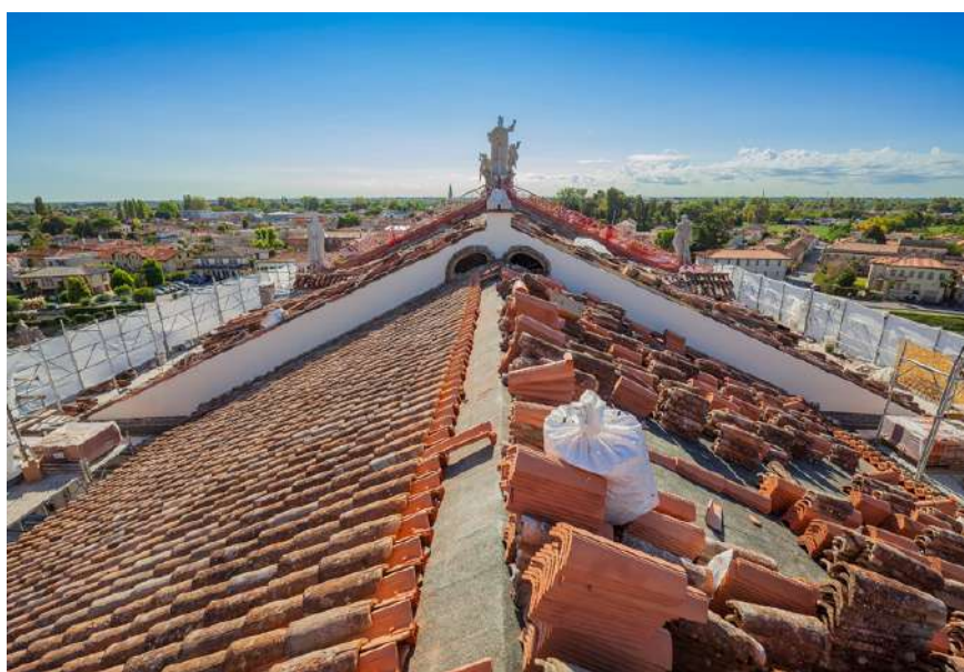
Nella storica Villa Pisani era diventato essenziale intervenire sulle coperture, in particolare quella dell'antico salone da ballo sulla cui cupola dimora un affresco di Tiepolo. Verificata la struttura portante lignea e inserito un nuovo pacchetto isolante, il sistema AERcoppo® ha permesso la posa dei coppi senza forare la guaina impermeabilizzante e, al contempo, la ventilazione del manto.
