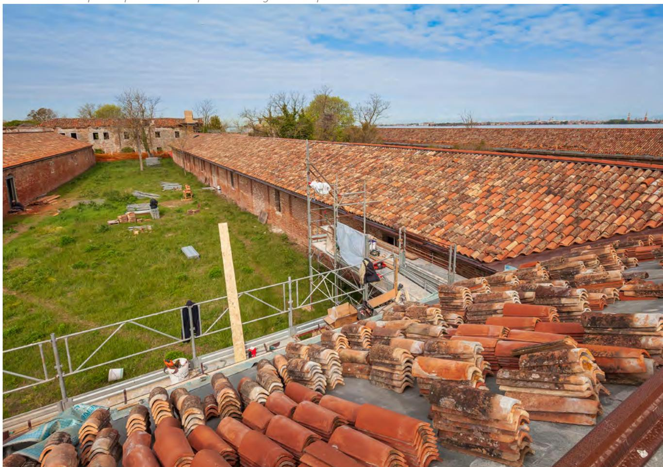
L'impiego del sistema **AERcoppo®** ha l'obiettivo di assicurare la resistenza della copertura nel tempo anche in un contesto particolarmente complesso per quanto riguarda l'azione degli agenti atmosferici ma anche costituisce una soluzione leggera per non gravare su strutture storiche con un equilibrio comunque delicato.
